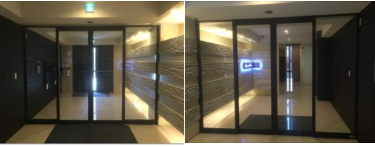
エントランス部の内外につながる感じる引分自動ドアになります。
