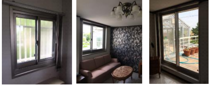
カバー工法にて、既存の窓枠を外さずにアルミサッシを新しく取付させていただきました。
