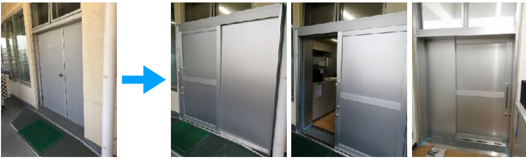
親子開きドアから片引セミオートに改修しました。 開放時 内から見た写真
