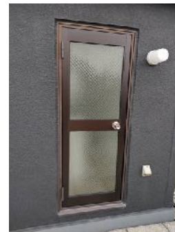
扉本体のみ交換の工事
