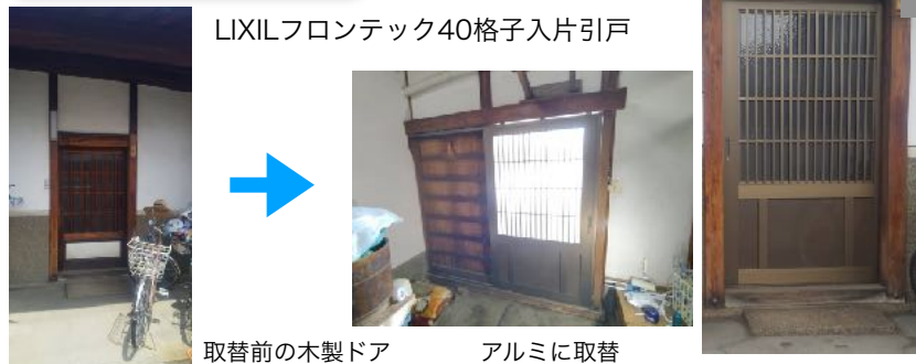
取替前の木製ドア アルミに取替
