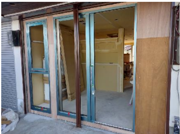
(株) 太陽トヨ住器 竹村様 八尾現場 STフロント70片引戸袖FIX
