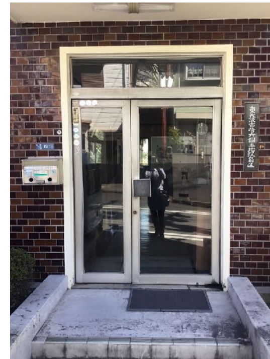
既設のフロアヒンジが痛んできたので、フロアヒンジドアを丁番ドアに取り替えさせていただきました。右下のところ、ちょっと黒くなってるでしょ？ フロアヒンジの油が漏れています。丁番ドアでもう心配はありません。今回もお仕事頂き有難うございました。
