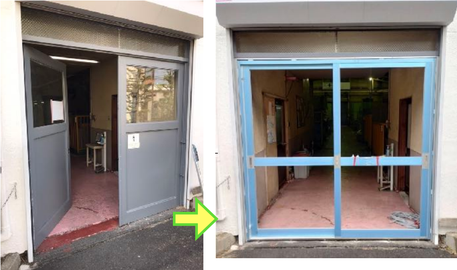
スチールドアの扉だけを外して、アルミサッシを入れています。有難うございます。
