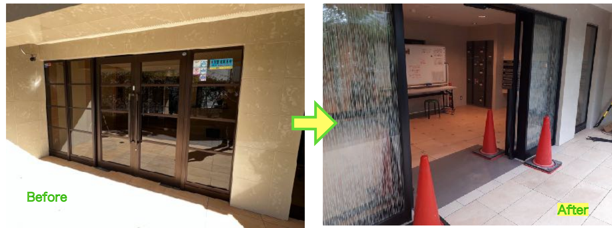
(株) シーズカーサ 古川社長様分 上池田某マンションエントランス KC色 STフロント140FIX+直付引分オートドア
