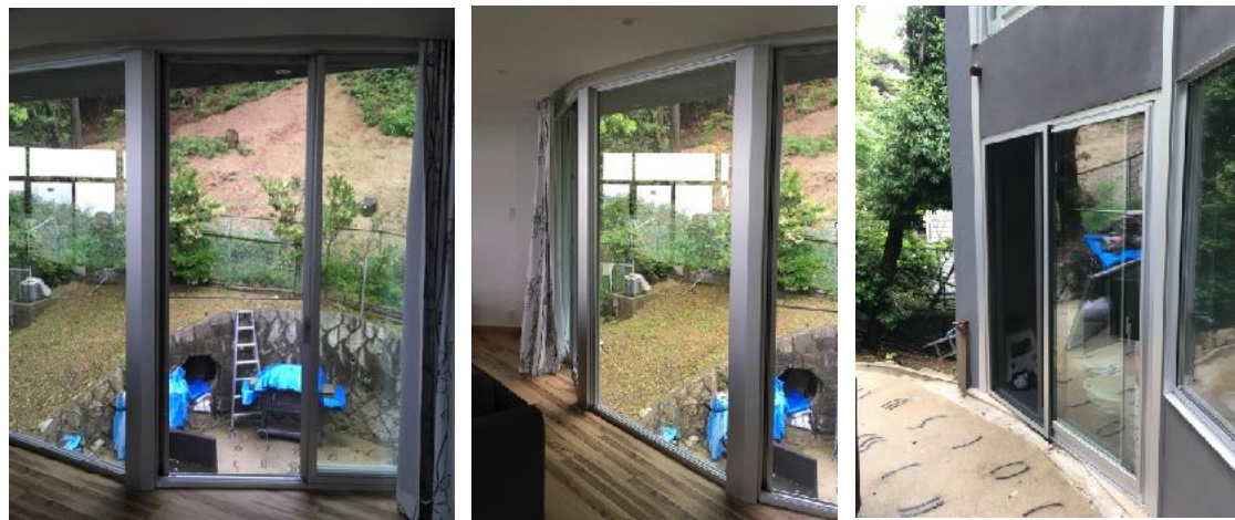
和田トーヨー住器（株）岡本様分 芦屋現場 SLC色 MTG70R複層引違窓、FIX
