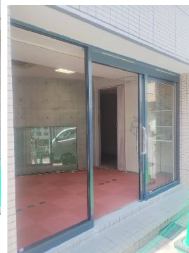
(株)太陽トーヨー住器 竹村様分 西区現場 STフロント70袖FIX付 片引セミオートドア ガイドローラー仕様
