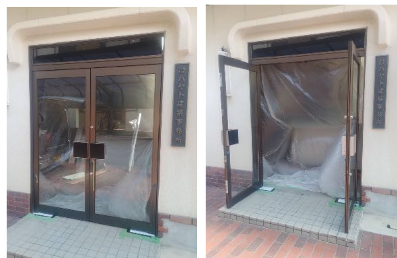
(株)太陽トーヨー住器 矢野様分 生駒現場 フロンテックDT40両開FHドア+フロアヒンジ交換
