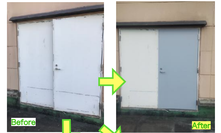
(株) リアル 社長様分 宇治市現場 DT40 スチールドア 本体親ドア取り替え 両開きドアの親ドアのみ取替え。子ドアの上下にフラッシュボルトが付いていました。親ドアの方にあるボルト受けの寸法を細かく採寸して既設のフラッシュボルトが使えるように作らせて頂きました。
