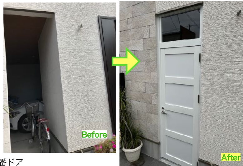
(株) リアル 社長様分 宇治市現場 DT40 スチールドア 本体親ドア取り替え 両開きドアの親ドアのみ取替え。子ドアの上下にフラッシュボルトが付いていました。親ドアの方にあるボルト受けの寸法を細かく採寸して既設のフラッシュボルトが使えるように作らせて頂きました。
