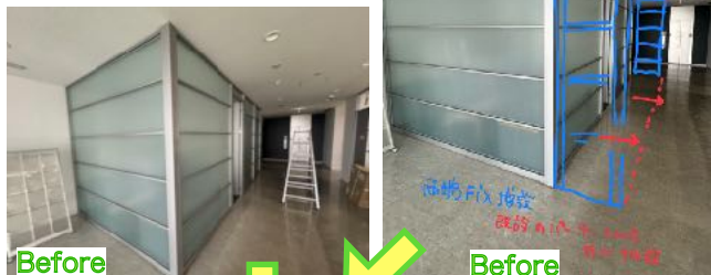
(株) 小川技硝 藤井様分 きんでん加古川 LIXILフロンテック70FIX 既設のサッシが付いているスペースを広げたいとのことで正面の部分のサッシを前に持ち出して移設しました。持ち出した分のFIXを既設のサッシのデザインに合わせて作らせて頂きました。無事に納まりました。今回も有難うございました。
